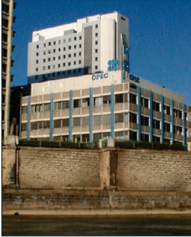
مبنى منظمة أوبك في فيينا
