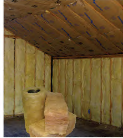
الشكل ٧ تعمل المواد العازلة في المنازل والبنائيات على تقليل انتقال الطاقة الحرارية بين الهواء داخل المنزل والهواء خارجه.
