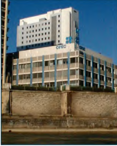
▲ مبنى منظمة أوبك في فيينا
